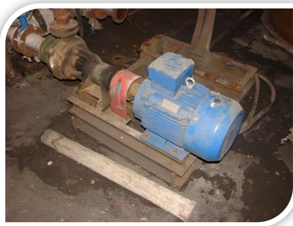
**Рисунок 1.2.1.3 Насосное оборудование котельной.**
